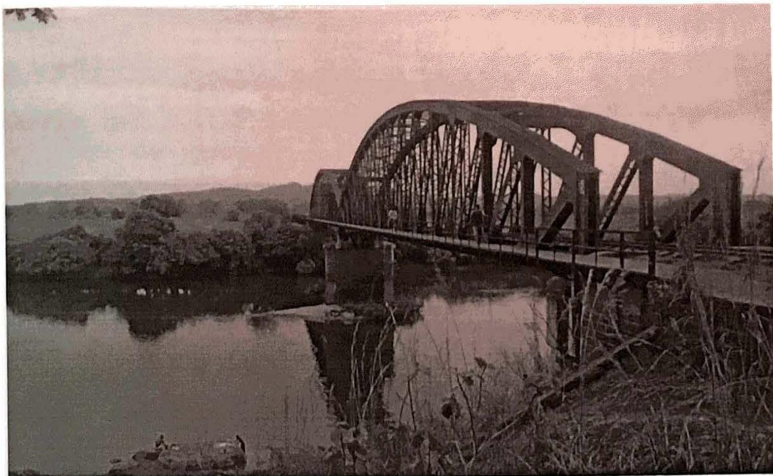
**PK588:** Pont métallique de 150 m sur le Niger / 02 travées de 75 m de portée / 12-15 tonnes à l'essieu (Structure métallique en bon état) / A reconstruire
