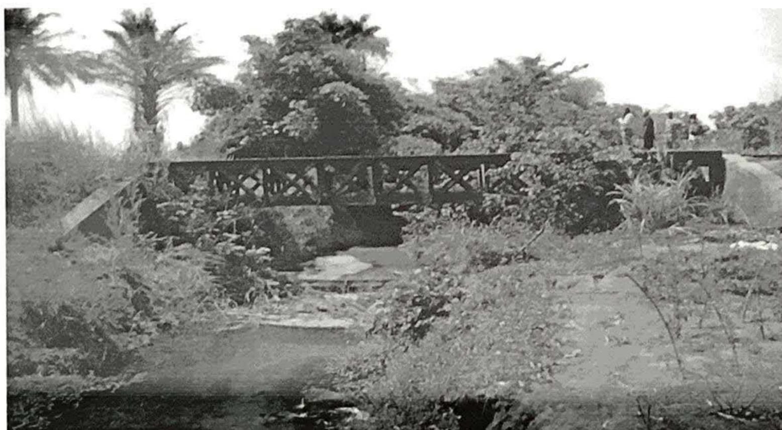
**PK13:** Pont métallique de 10 m à poutres principales latérales à treillis / 12 tonnes à l'essieu / A remplacer
